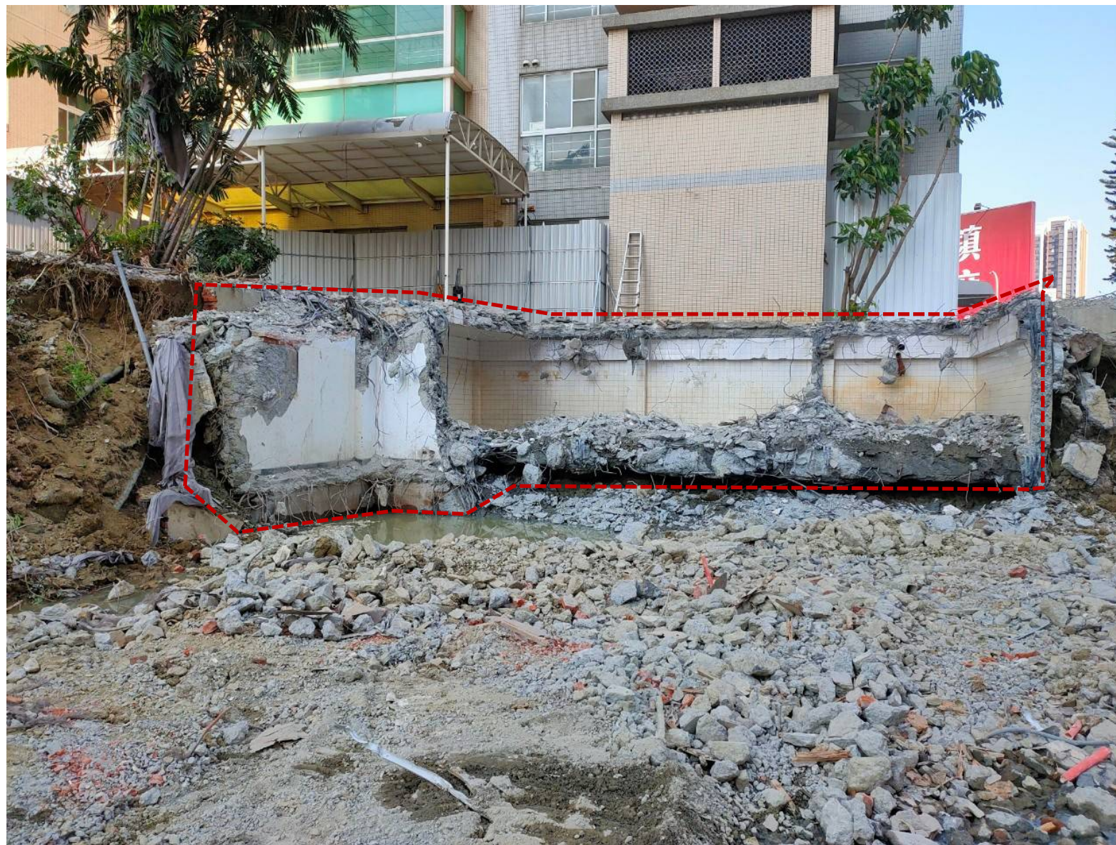
部分尚未拆除之地下水箱
