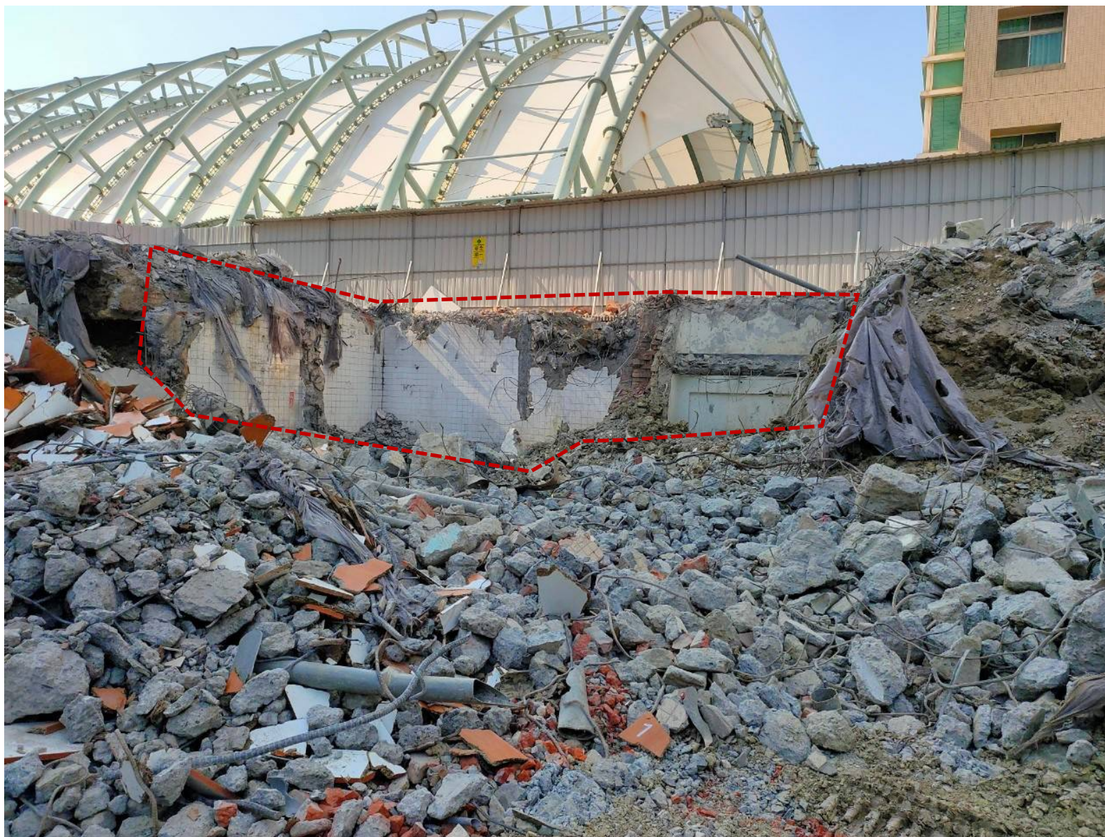
部分尚未拆除之樓梯間區域
