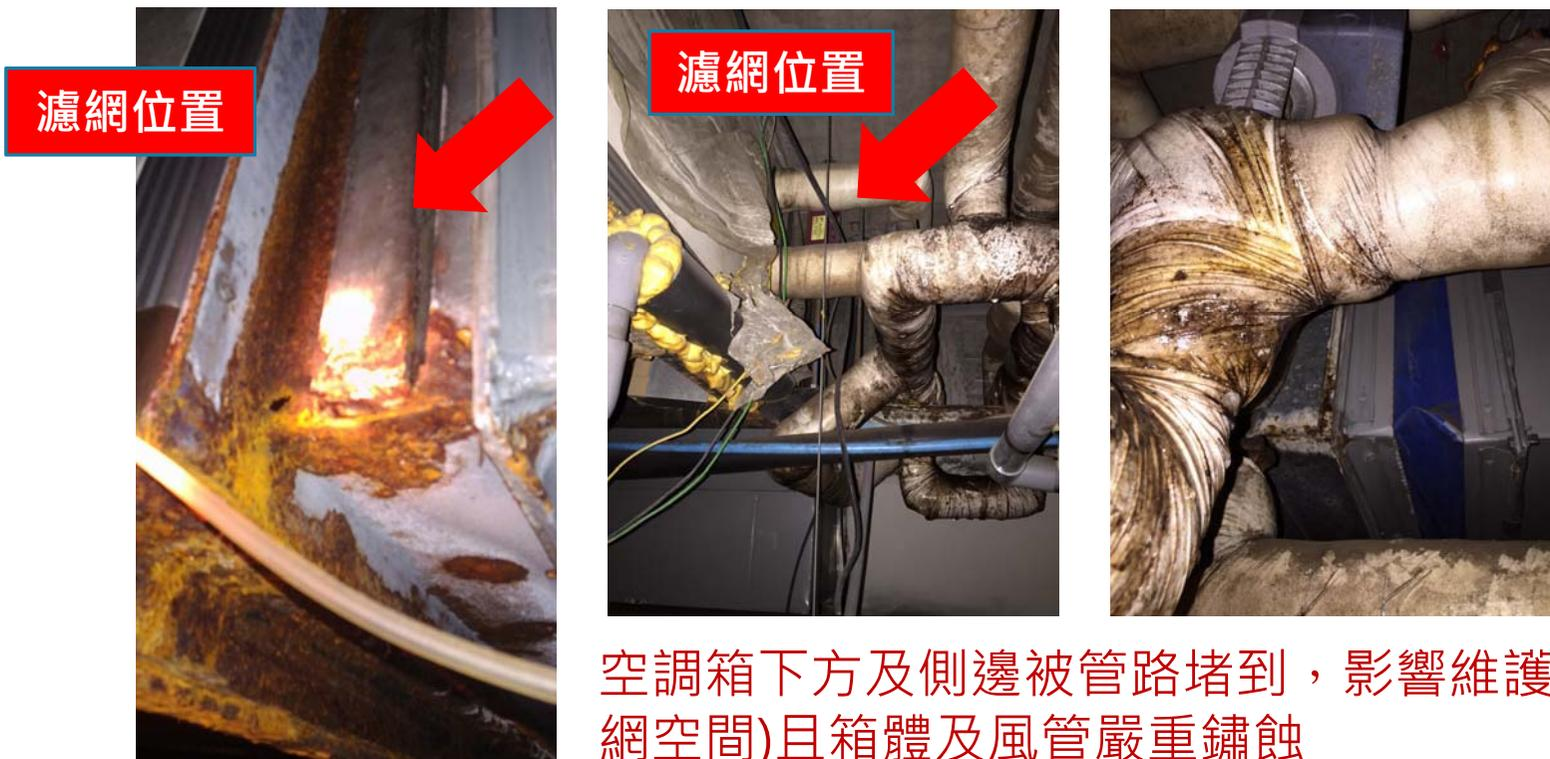
空調箱下方及側邊被管路堵到，影響維護(換濾網空間)且箱體及風管嚴重鏽蝕
